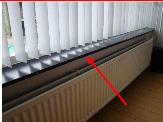
Dorpsweg 14: Foto 1 | Foto voor bron Vensterbank
