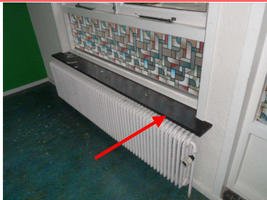
Dorpsweg 18: Foto 3 | Foto voor bron Vensterbank
